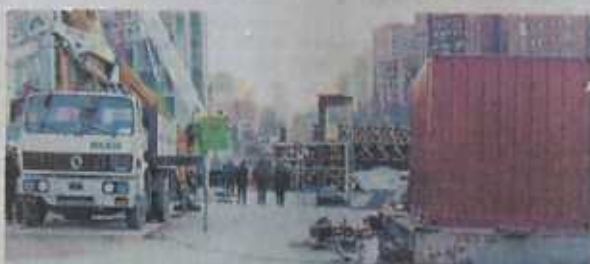
Trabajos para la construcción de la explanada del Fórum 2004.
